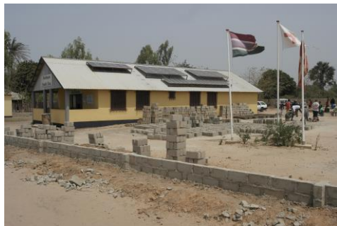
Frivillige bygger mur omkring sundhedscentret.
