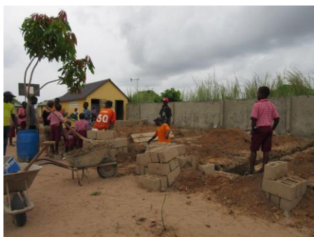
Sokkel og gulv til de nye klasseværelser.
